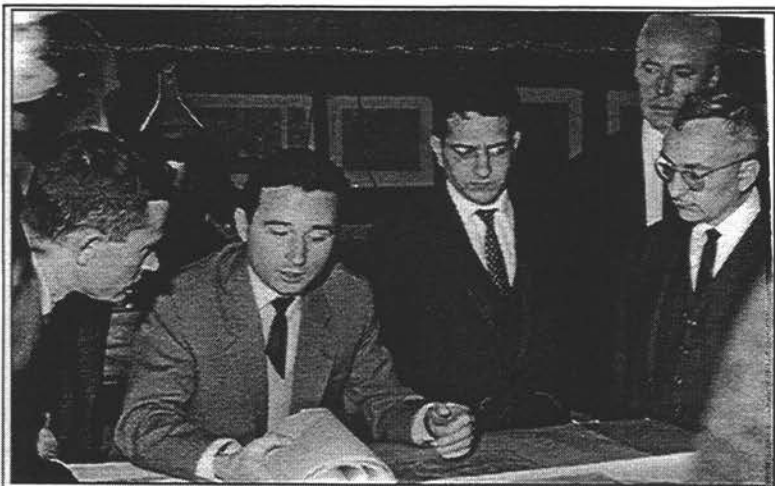
Une visite du Conseil général des Mines dans les nouveaux bâtiments du Service de la Carte géologique à Orléans (avant la fusion). On reconnaît Sore, Horgnies et notre directeur général, Nicolas.
