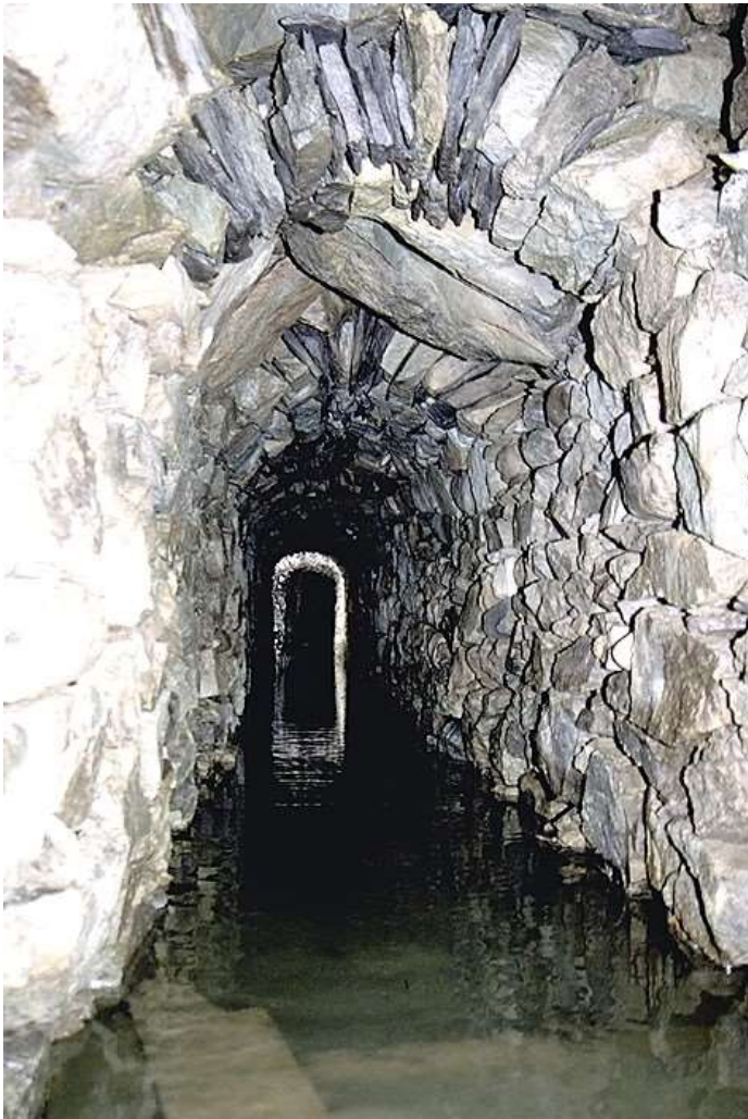
2 Vallauria : Galerie d'exhaure Carlo Emmanuele percée en 1784 et ici murillée (photo Féraud)
